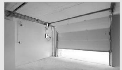
Mit einer geringen Anschlagbreite von **nur 80 mm** je Seite, stellen Novoferm Sektionaltore die ideale Lösung für die Renovierung dar.
