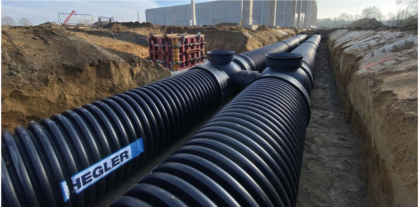
Rückhaltesystem mit integrierter Querverbindung am Schacht MULTI-inspect
