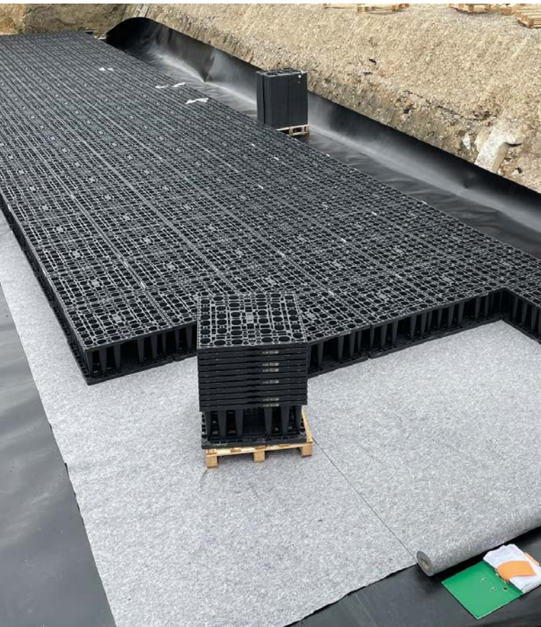
GRAF EcoBloc Inspect smart Modul lässt sich platzsparend ineinander stapeln und reduziert das Transportvolumen zum Einbauort
