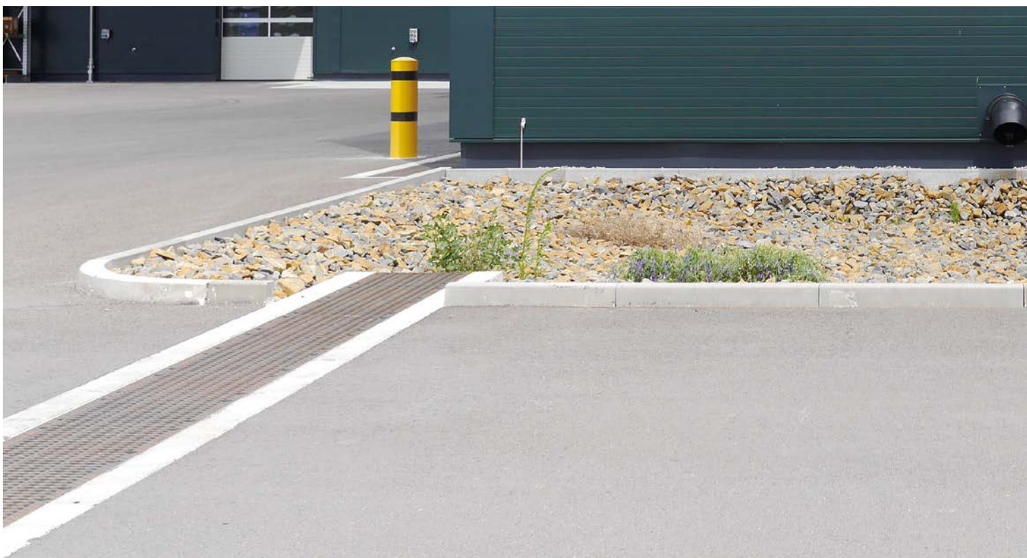
Das anfallende Wasser des 20.000 qm großen Flachdachs wird ebenfalls über die BIRCOsir-Rinnen auf dem Gelände in die Versickerungsmulden geführt
