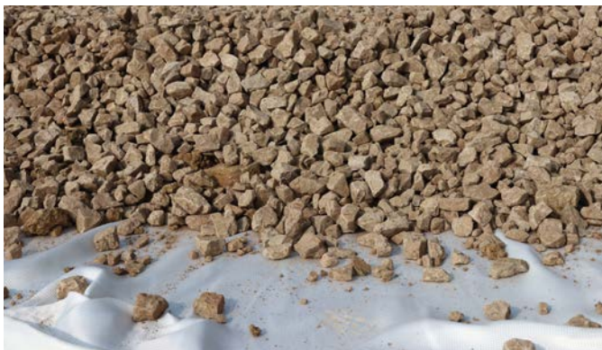
Baustraße, ungebundener Oberbau bewehrt mit PET-Hochlastgewebe
