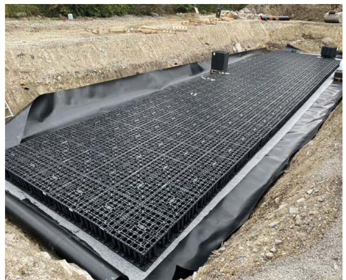
Vor Ort wurden 320 GRAF EcoBlocInspect smart Module zu einem Blockverbund montiert
