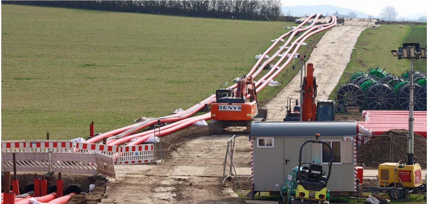
Blick auf die Trasse
