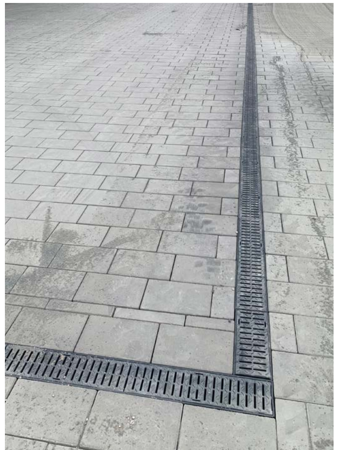
Im Einbau deutlich erkennbar die durchgängige Rinnenführung zur sicheren Ableitung von Oberflächenwasser
